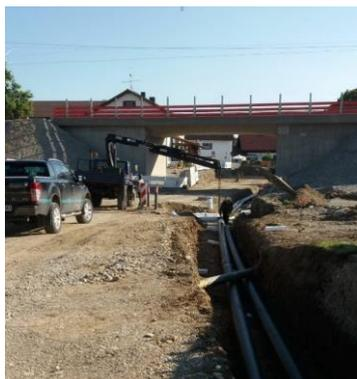
Abbildung 16: Im Bereich der Bahnunterführung wurden im Herbst 2018 bereits vorsorglich Wärmerohre verlegt, um diesen Teil der Straße zu einem späteren Zeitpunkt nicht mehr aufreißen zu müssen. Foto: Gemeinde Westerheim
