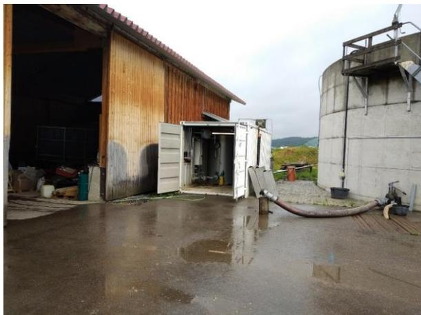
Abbildung 41: Biogasanlage der Familie Gollmitzer im Unterallgäu. Aktuell wird die 2005er Biogasanlage im Grundlastbetrieb betrieben und versorgt bisher nur den Wärmebedarf der Vergärungsanlage und der Container-Holztrocknung.
