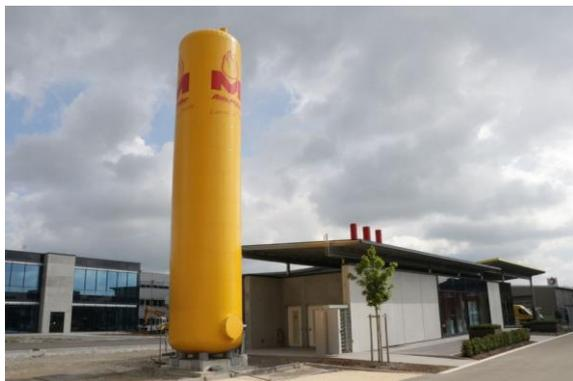
Abbildung 62: Pufferspeicher an der Heizzentrale auf dem Firmengelände der Green Factory 2.0
