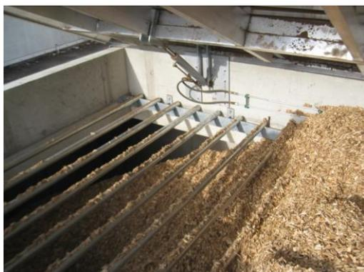
Abbildung 19: Hackschnitzellager in Boos. Lösung als Bunkeranlage zur größtmöglichen Platzersparnis. Die Befüllung mit dem LKW kann problemlos erfolgen. Foto: Knecht Ingenieure
